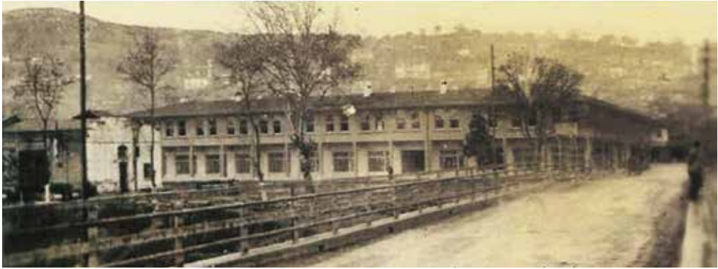
Biga Elektrik Santrali Belediye Binasının yanında hizmet görüyordu. Jeneratörün motorunun soğutma suyu için kullanılan havuz ise "Belediye Parkı"na güzellik katıyordu.
