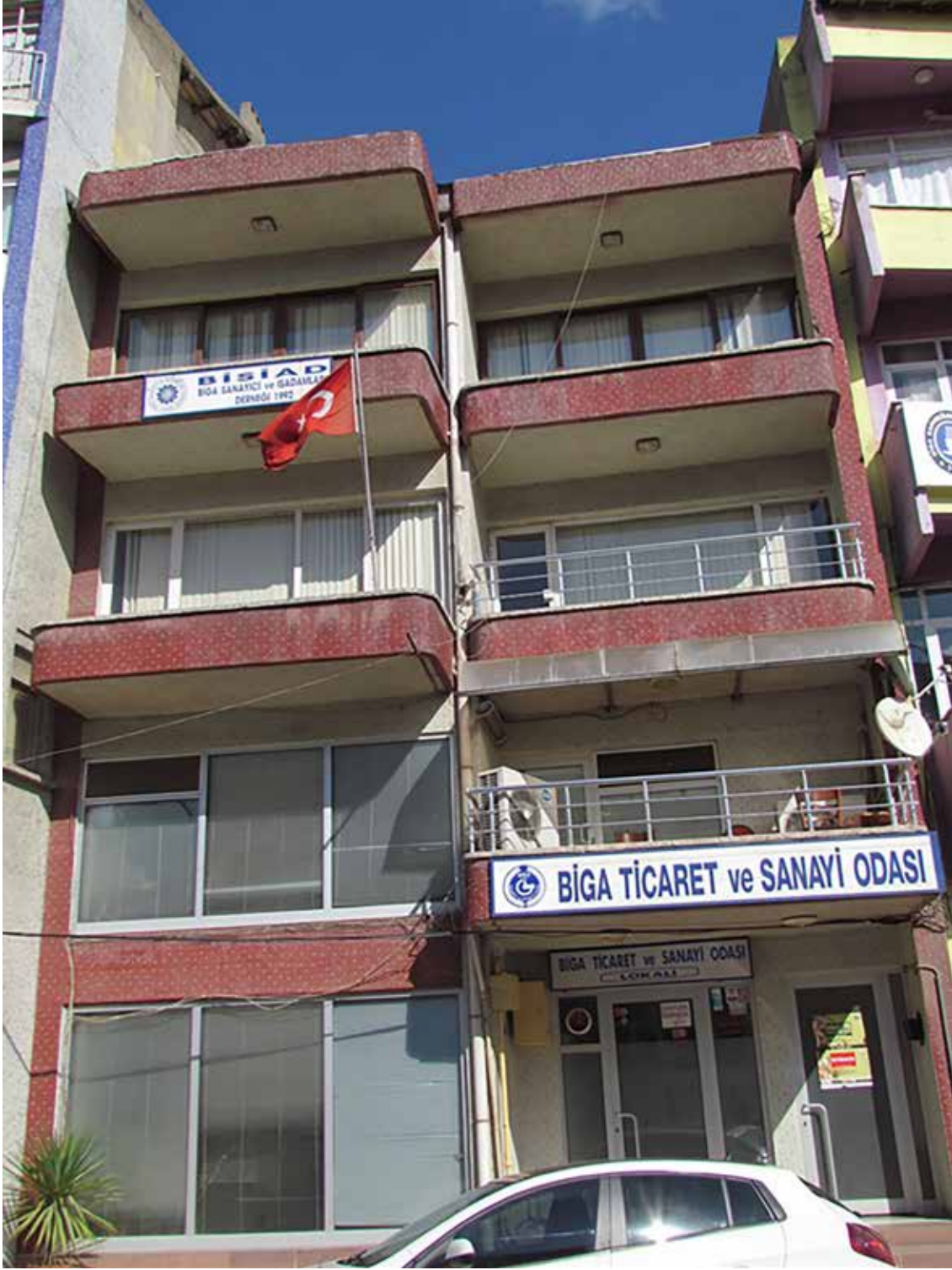
Biga'nın ticaret ve sanayisine 1986-2016 yılları arasında hizmet veren İnönü Caddesi üzerindeki Biga Ticaret ve Sanayi Odası hizmet binası
